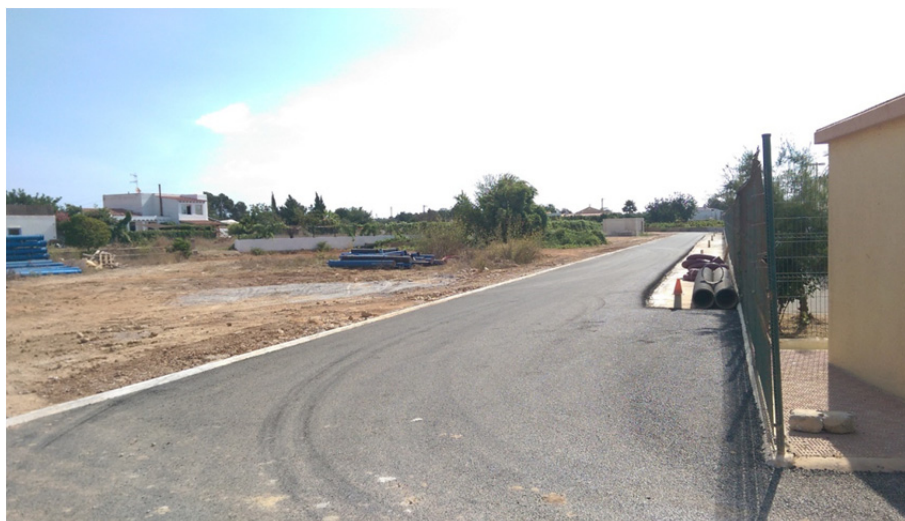
Imagen 3. Vial nuevo, colindante a zona de actuación.
