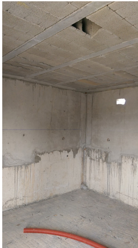
Imagen 11. Interior caseta existente en parcela.
