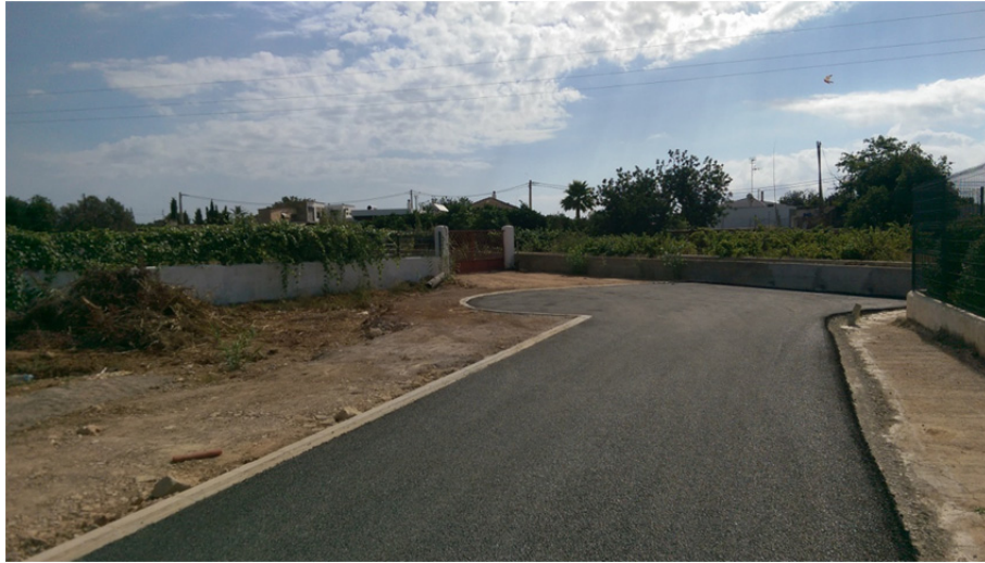
Imagen 4. Final del vial nuevo, colindante a zona de actuación.
