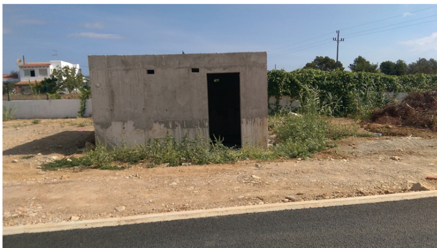
Imagen 9. Caseta existente en parcela.
