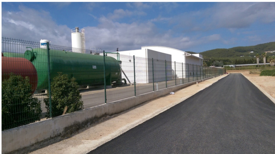
Imagen 16. Nuevo vial colindante en sentido de salida, junto zona IDAM.
