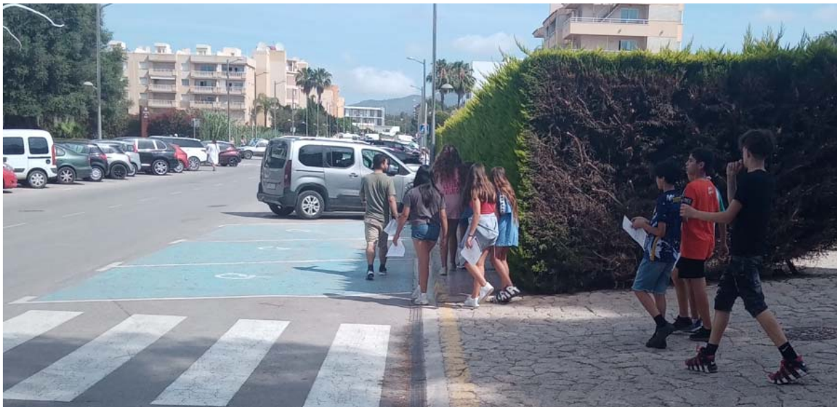
Imagen 12. Detalle sección tramo C/ Salvador Camacho frente al acceso principal al Palacio de Congresos, perspectiva sentido montaña. Paso peatonal y plazas PMRs. Fuente: elaboración propia
